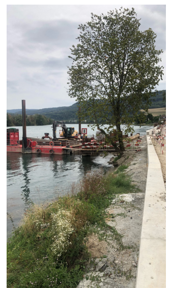
Titelbild: Bau Hochwasserschutz Foto: Bruno Grüter
