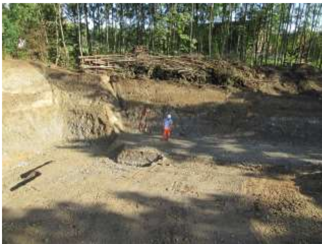
Fortschritt des Anbaus am 14. September
