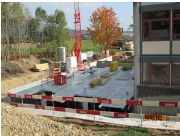
Fortschritt des Anbaus am 21. Oktober
