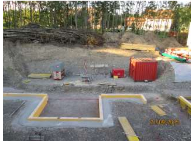
Fortschritt des Anbaus am 21. September
