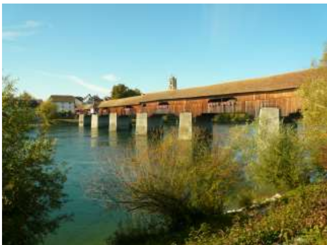
Die historische Holzbrücke von Stein AG nach Bad Säckingen.
