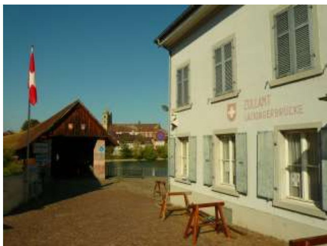
Das ehemalige Zollamt Säckingerbrücke, Polizeiposten von 1804 bis 1848, in Stein AG.
