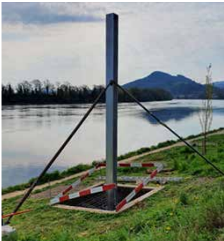
Eisenträger wurden einbetoniert
